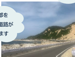
珠洲市仁江町 通行止めのトンネル を迂回する仮設道路 (2025.4)
