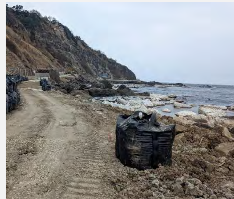
B集落に続く道路の“仮復旧後”の状況 (阿部撮影)
